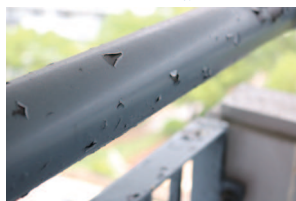
塗膜硬度 B 前後の塗料で摩耗を繰り返した場合 (イメージ) (塗膜が柔らかい為、頻繁な摩耗・歩行・洗浄には向きです)
